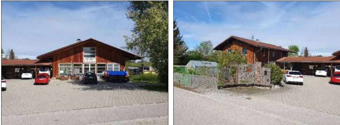
Abb. 2: Südansichten des Plan-/Baugebietes gemäß [d]; links - Schreinereigebäude (Bestand), rechts - Betriebsleiterwohnhaus (Bestand)
