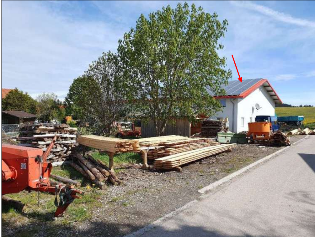
Bild A08: Werkhalle mit Büronutzung In der Ob 7 (IO11)
